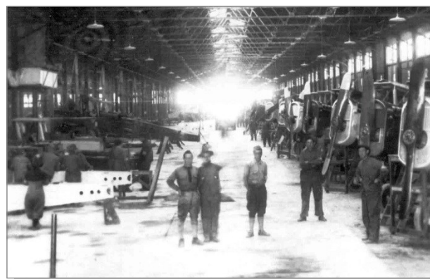
11 Bâtiment d'assemblage des DH4 du Air service production center N°2 de Romorantin ©
